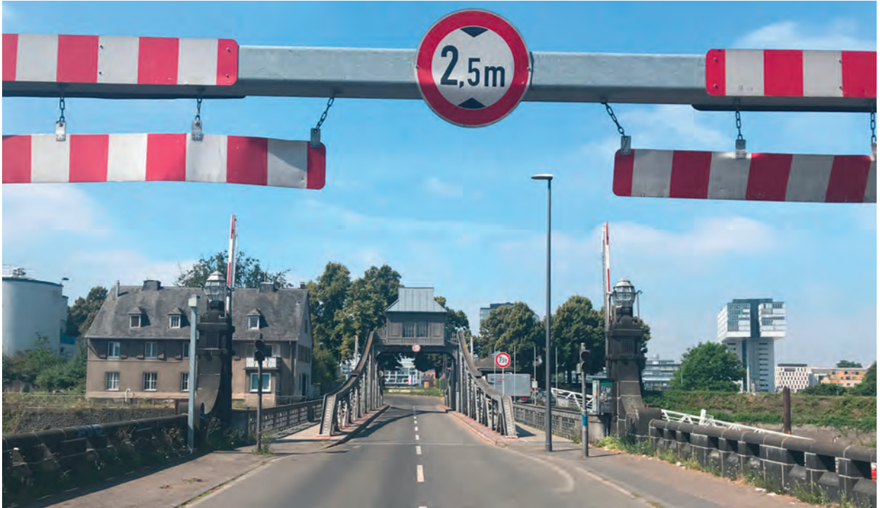
Abbildung 19: Deutzer Drehbrücke – Einfahrt zum Planungsgebiet Deutzer Hafen (Quelle: Kähler)
