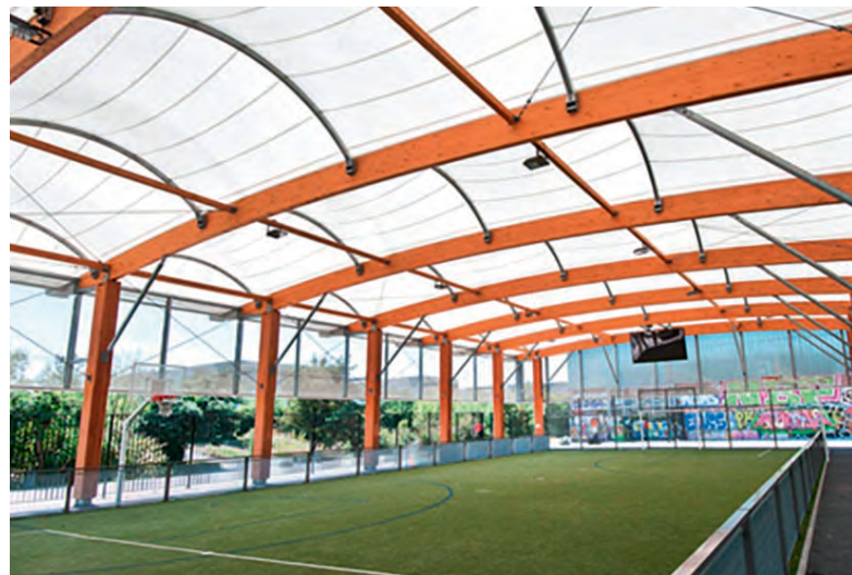
Abbildung 27: Beispiel klimaoffene Halle ( https://www.sportstaettenrechner.de/wp-content/uploads/2017/11/Freiluft-Sporthalle-Soccerhalle.jpg )
