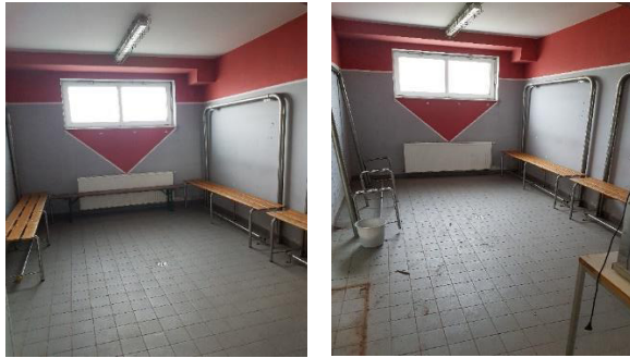
Vorher Kabinen (Kabine 1. M.)
