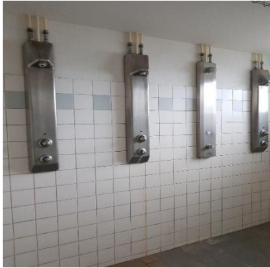
Vorher Duschen Kabinentrakt
