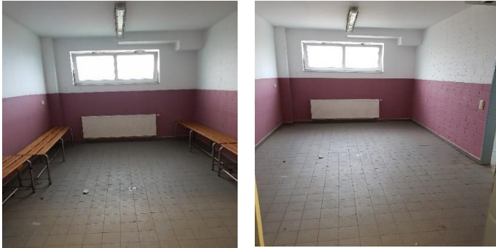
Vorher Kabinen (Kabine 3. M.)
