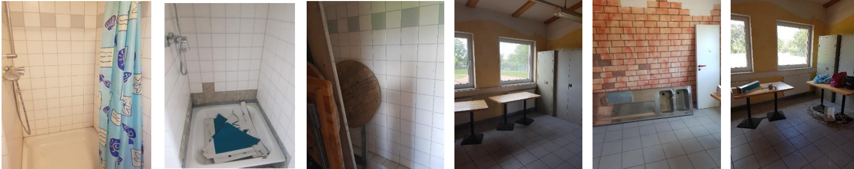
Vorher Schiedsrichterraum mit Dusche
