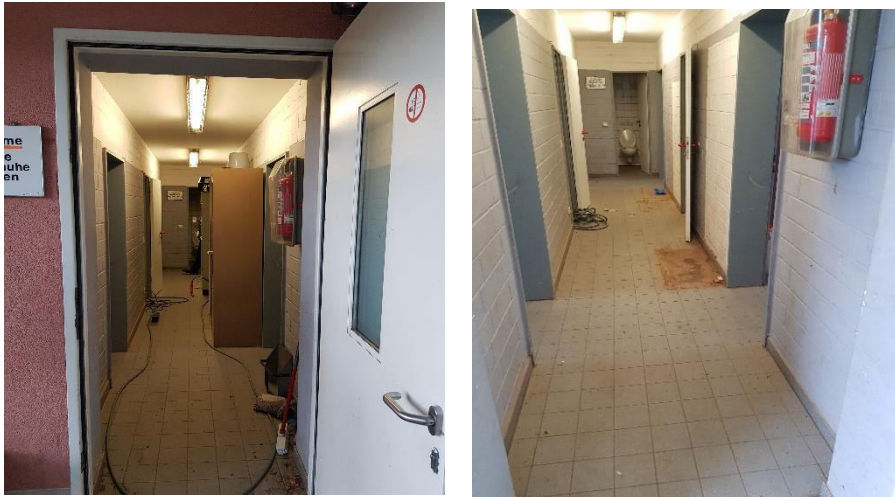
Vorher Kabinentrakt Flur
